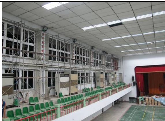
6. 噴霧系統安裝前
