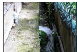
圖二、地下水排水至水溝
