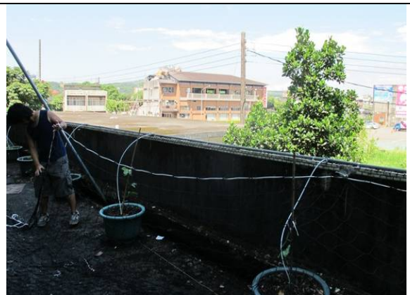
5. 自動灌溉系統安裝後
