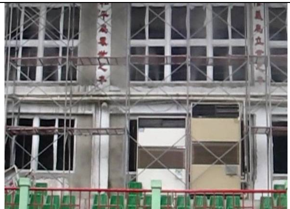
6. 噴霧系統安裝後噴霧情形
