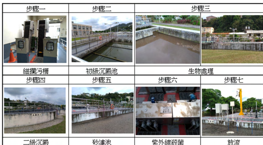
圖八：大溪水資源回收中心處理單元流程圖 (資料來源：本研究自行拍攝整理)
